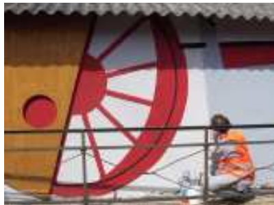
Arbeit am Gebäude
