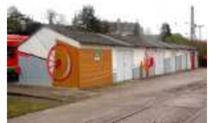
Das Gebäude nachher
