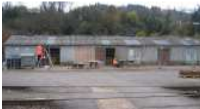
Das Gebäude vorher
